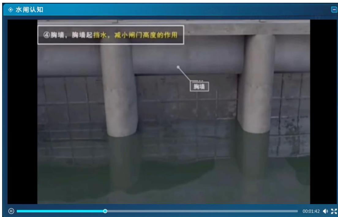
(4) 水闸组成结构：水闸组成包含闸室、底板、闸墩、工作桥、消力池、海漫、防冲槽、铺盖、翼墙。
