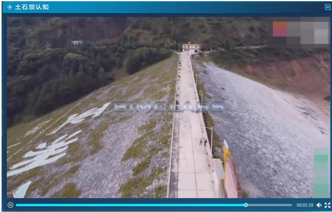
(3) 土石坝组成结构：土石坝组成包含坝顶、上游护坡、下游护坡、坝面排水、防渗体、坝体排水、反滤层、过渡层、溢洪道。
